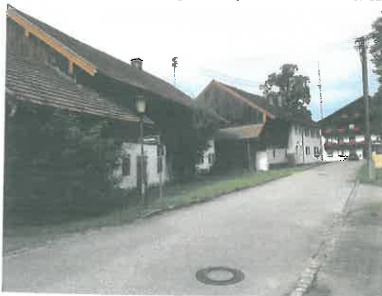
Raumkanten im Alten Kirchenweg in Richtung Westen
