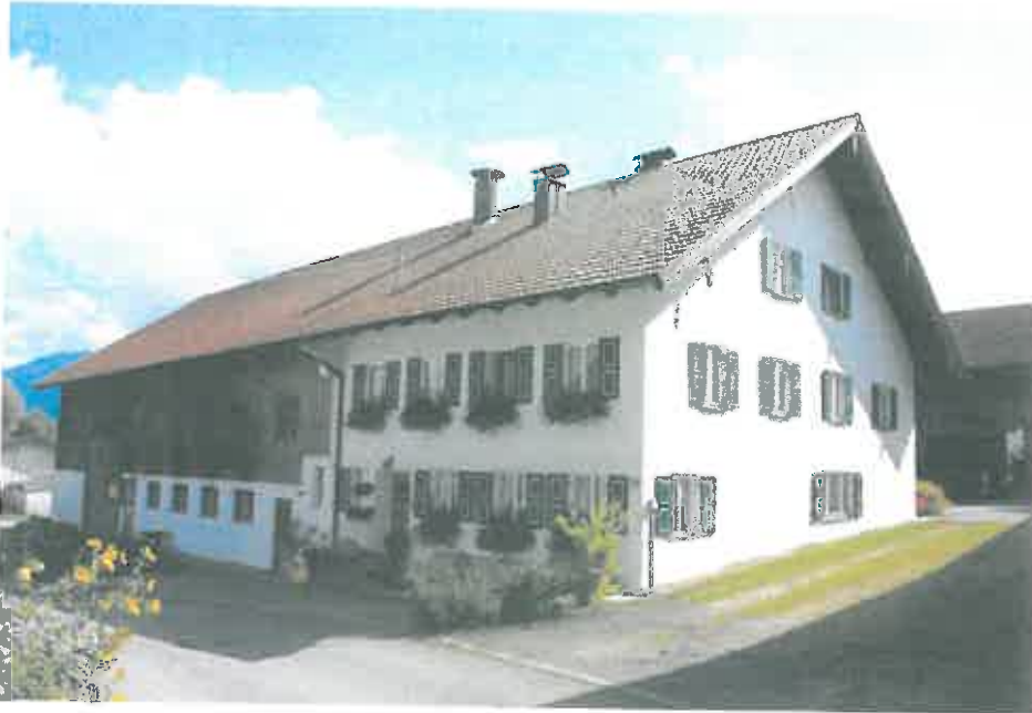
Bauernhaus im Alten Kirchenweg – Einfirsthof mit geputztem Wohnteil und Holz-Putzfassade am Stallteil – ortsbildprägendes Gebäude
